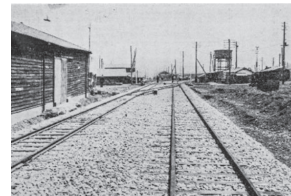
福崎で1957年5月に開通した当社専用側線。左手前の木造建物は当社の初代A号倉庫を移築したE号倉庫と思われる＝1957年
