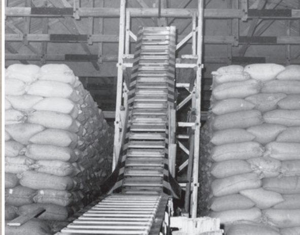
写真は左上から時計回りに①②天井を支える木骨トラスと1956年に購入したベルト・コンベヤーが見える③④輸入小麦の荷役作業。麻袋を補修する女性の姿も見える(中央右、頭にかぶりものをした2人)＝1956年ごろ⑤⑥はい付け(荷を整然と積み上げる)のため、やぐらを組んでいる。以上3点は、三突倉庫。⑦⑧(左から)A号、B号、C号、D号倉庫。左端が2代目A号倉庫＝1950年代と思われる
