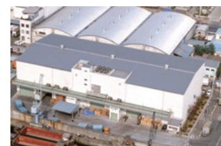
3代目 鉄骨造り、ALC板張り2階建ての定温倉庫。政府米、民間流通米、ココアを保管している
