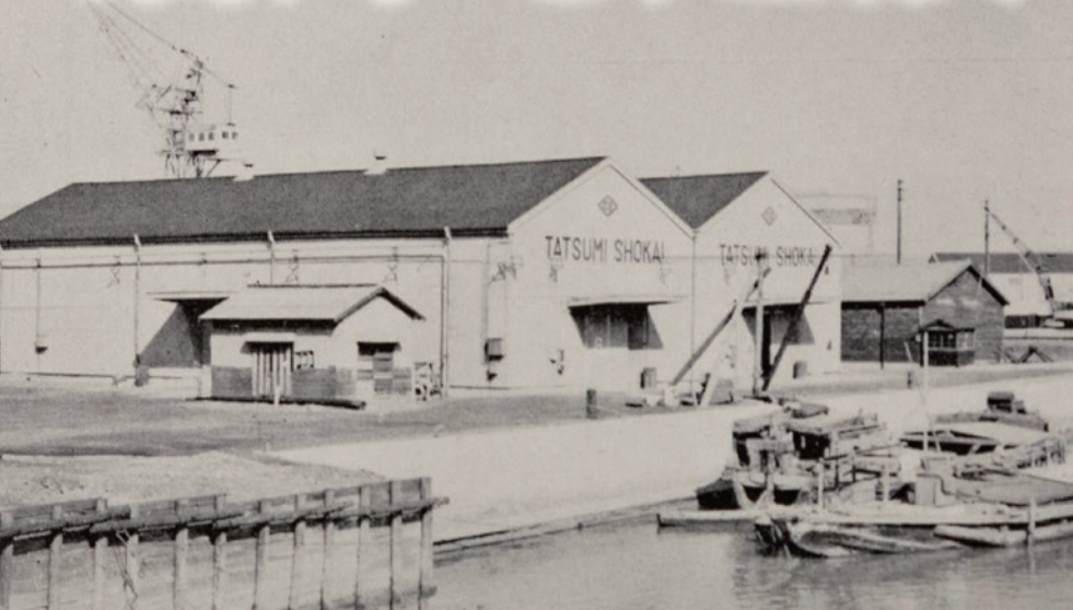
福崎に建設した(右から)E号、F号、G号倉庫。E号倉庫は三突基部にA号倉庫として建設され、その後、この地に移築したもの＝1960年前後
