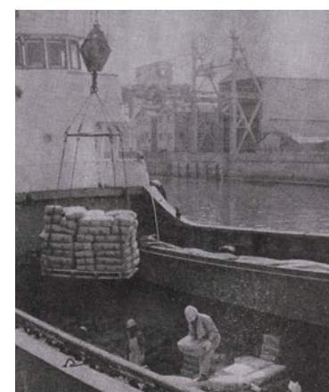
木津川岸壁でのソーダ灰の荷揚げ作業＝1980年
