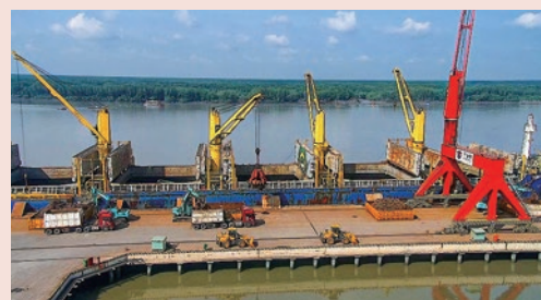
5万積載 ト 規模の船舶が接岸可能(現在は8万積載 ト が可能)な300 メートル の第1岸壁(水深13.5 メートル ) =2019年10月
