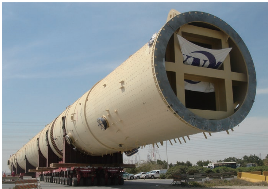
輸送中の長さ110m、重量1500トンのエチレンタワー =2010年
